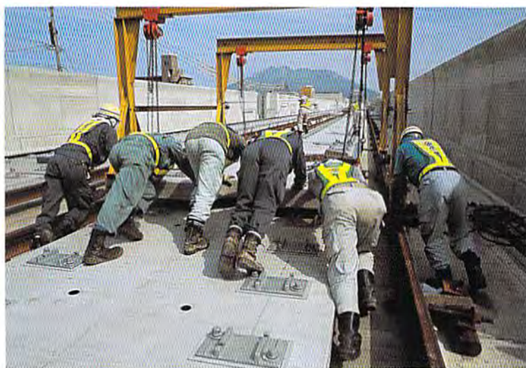
新幹線の線路の新設工事 (03年)
