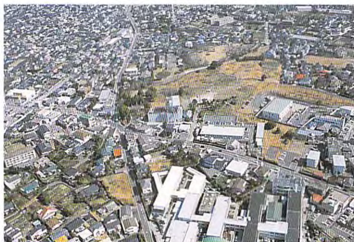
吉野区画整備工事が始まった(03年)
