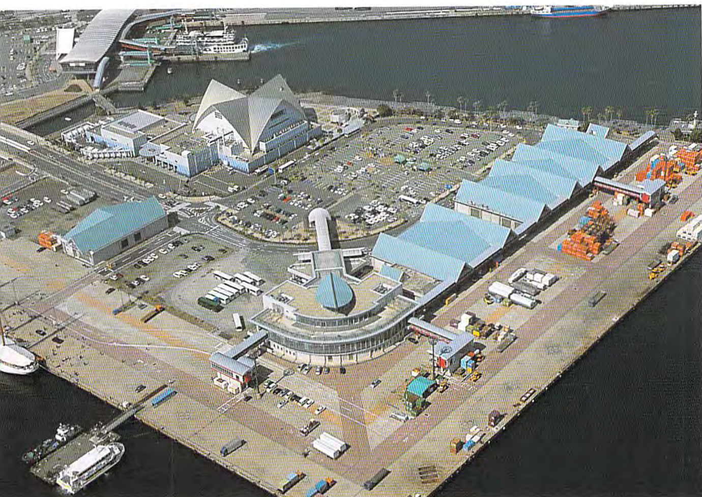
整備された鹿児島本港 (03年)
