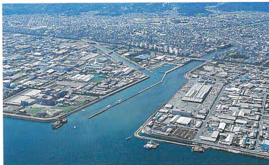
左に南部汚水処理場、右に中央青果卸市場がある永田川河口 (92年)
