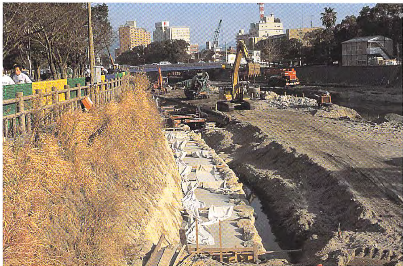
甲突川改修工事
