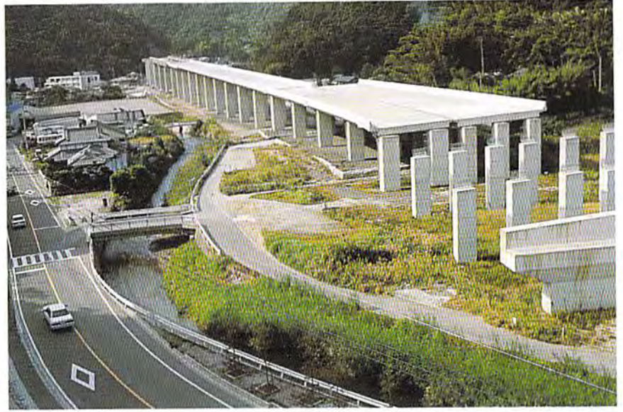
国道3号線バイパス工事 (92年)
