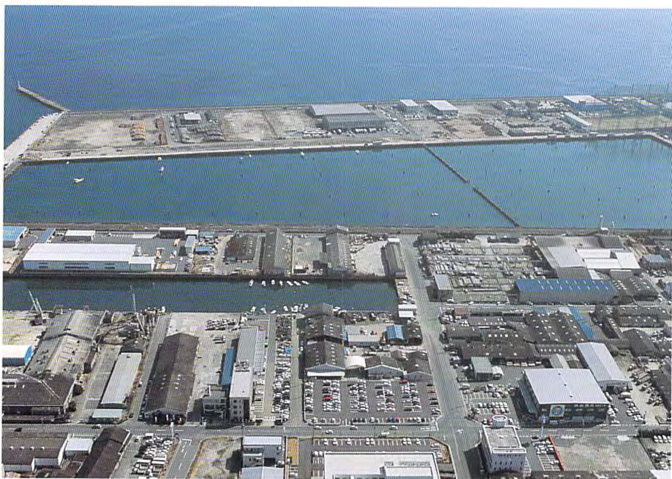
東開町の水中貯木場 沖に人工島工事現場
