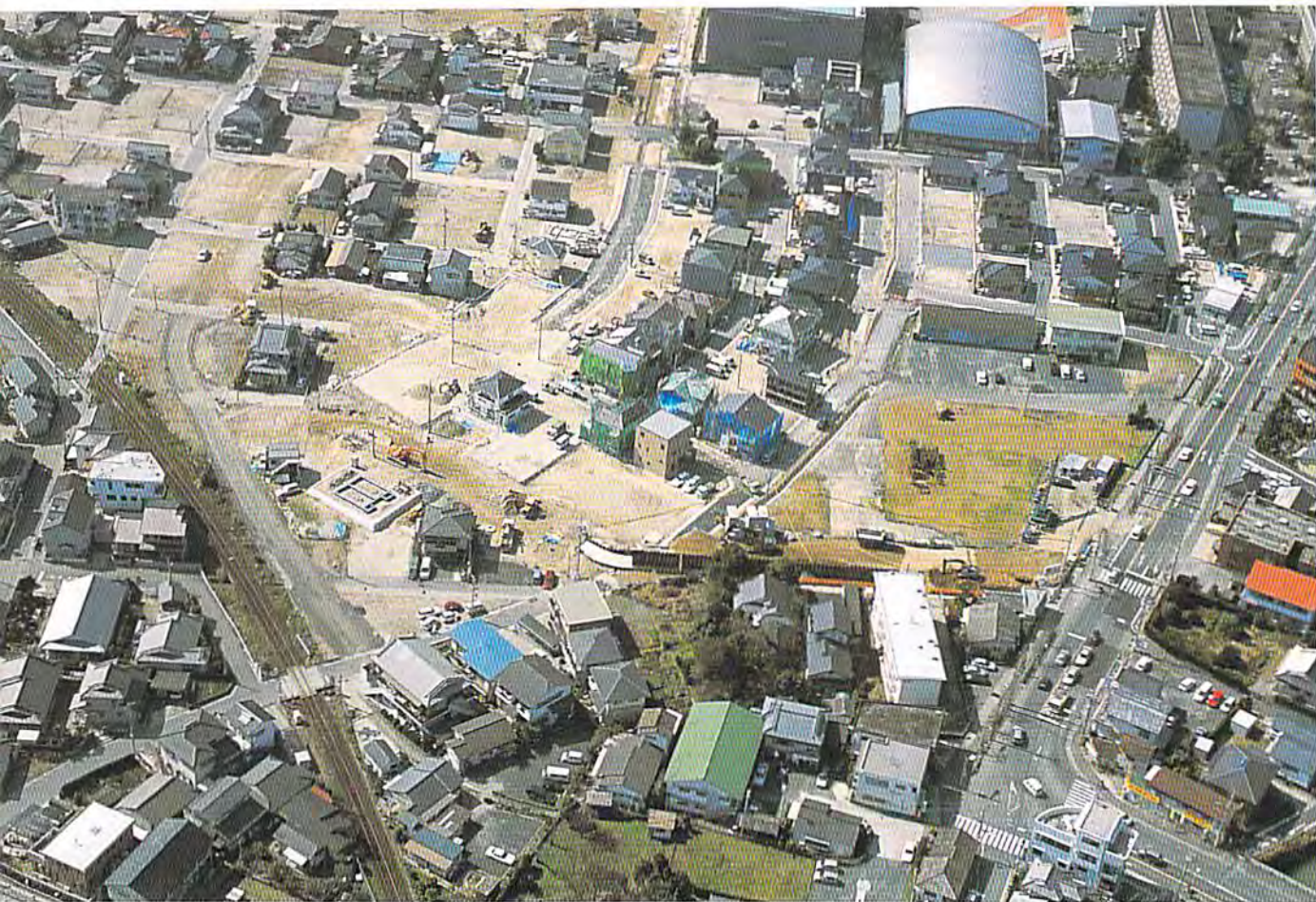
区画整備が進む谷山市街地
